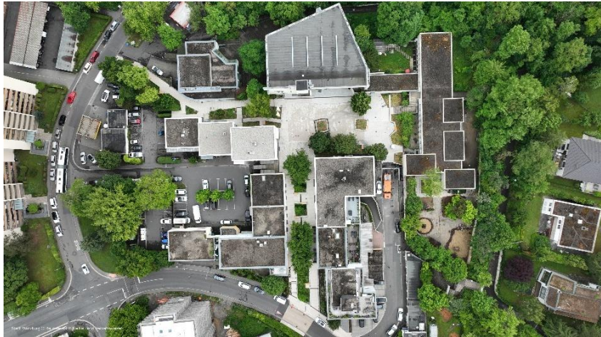
Abbildung 23: Kirchplatz St. Albert © Stadt Würzburg, Baureferat/FB Tiefbau und Verkehrswesen
